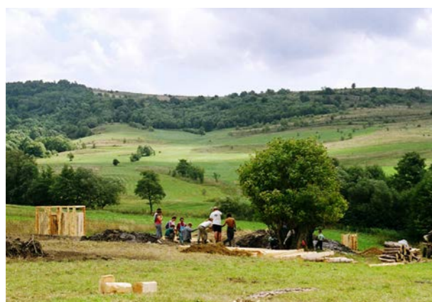
Construcción de los baños comunitarios Dungo Spa en 2006. Foto: Anna Varga
